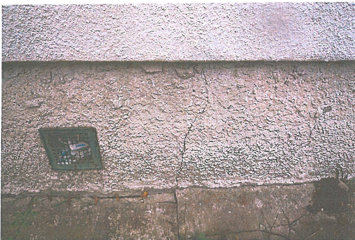
Trhlina mezi obvodovými panely
