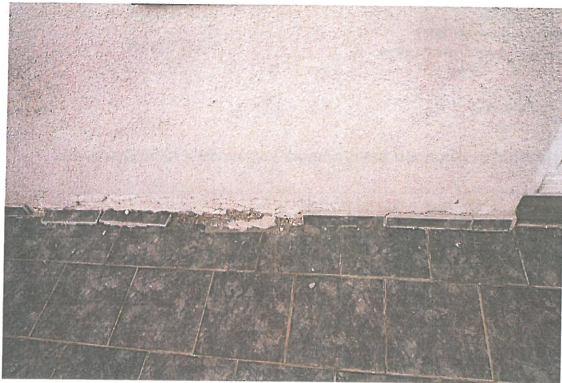
Zatékání do obvodové stěny v místě terasy
